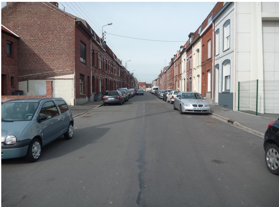
Photo 6: Rue pentue imperméabilisée à Halluin renforçant la vitesse des écoulements
